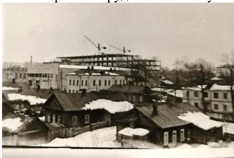
Институт строится. 1965г.
