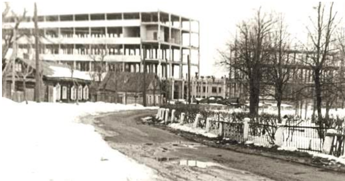
Сквер Мира. На заднем плане строительство ВНИИМЭТ.
