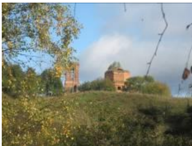
Церковь до восстановления.
